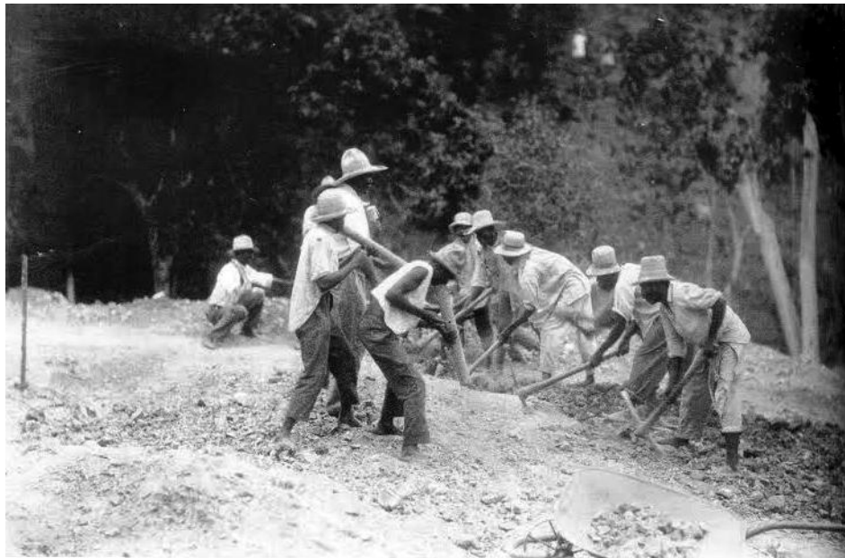
1/1/1918 : Ouverture officielle de la route reliant Port-au-Prince au Cap, construite par des paysans haïtiens travaillant sous les termes de la corvée, système établi par Geffrard en 1863.
