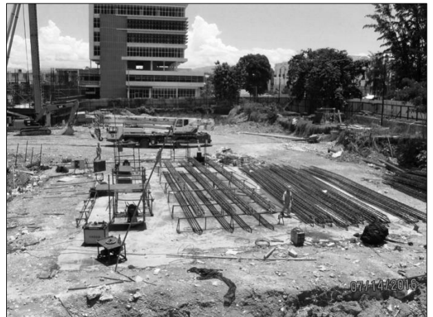
Travaux retardés sur l'édifice du MEF. Têtes de pieux. Armatures en préparation.
