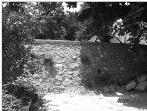
Mur de soutènement construit par le projet
