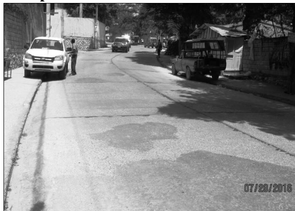
Réparations du revêtement en béton
