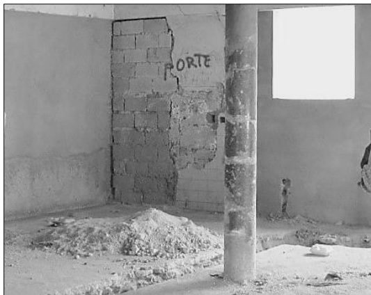
Phase 3, Lot 1: gros œuvre du bloc opératoire
