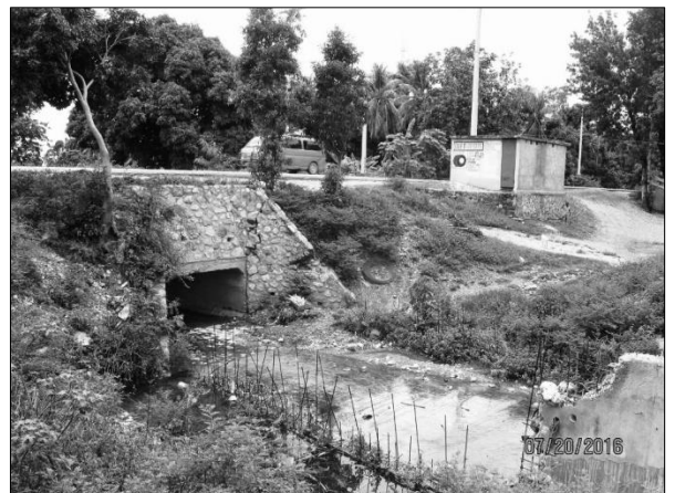
Murs de tête aux entrées du Dalot no. 2
