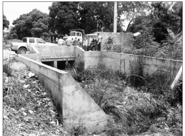
L'aménagement des bassins de dissipation d'énergie à la sortie du Dalot no. 1
