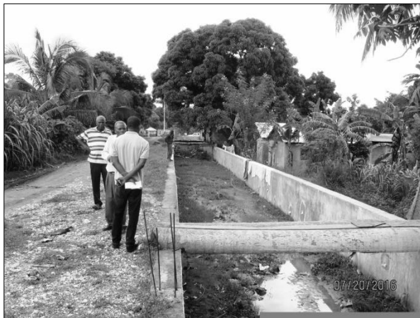
Mur de tête à l'entrée du Dalot 1
