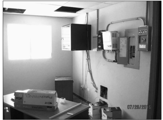
Installation d'équipements informatiques en cours dans le bloc administratif
