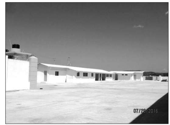
Vue extérieure du bloc administratif
