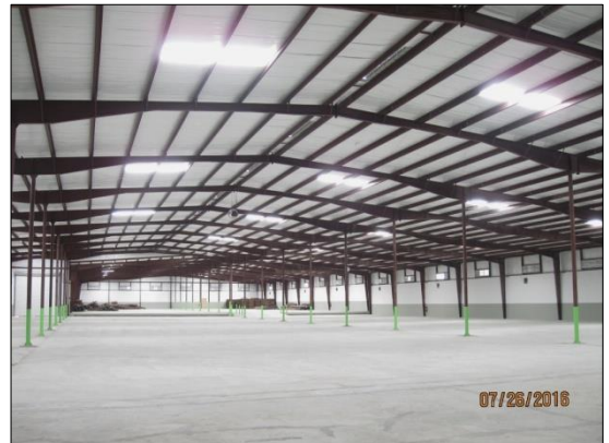
Intérieur du hangar
