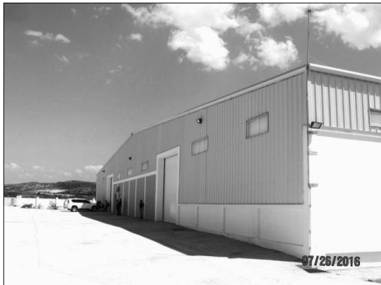
Extérieur du hangar
